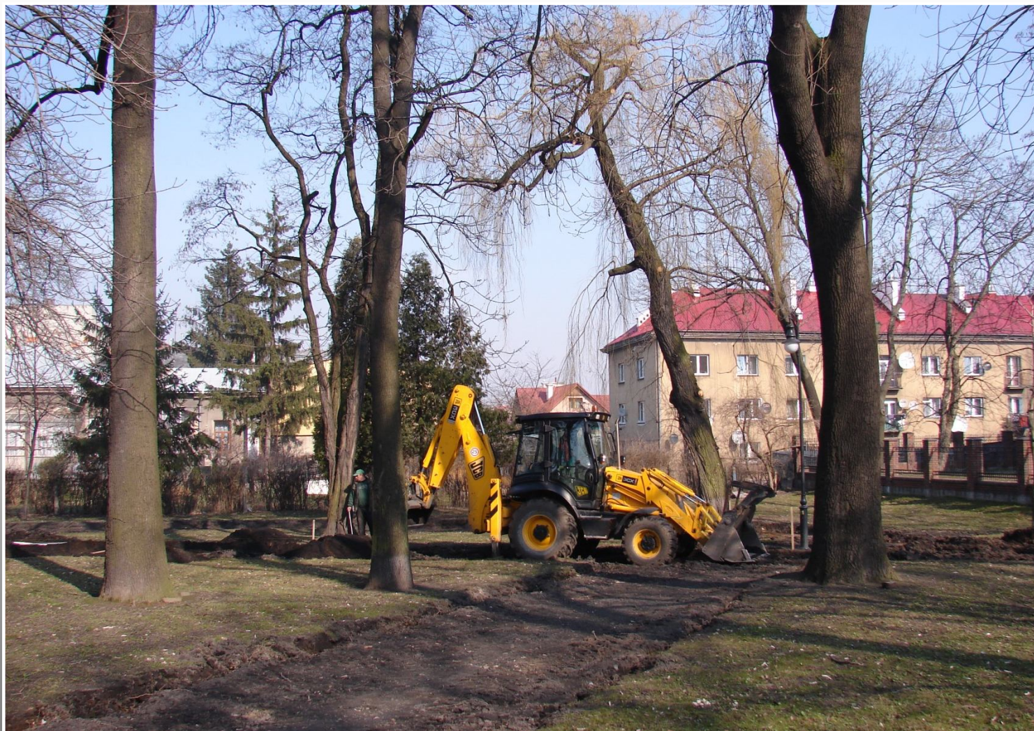
Widok na teren prac remontowych.
