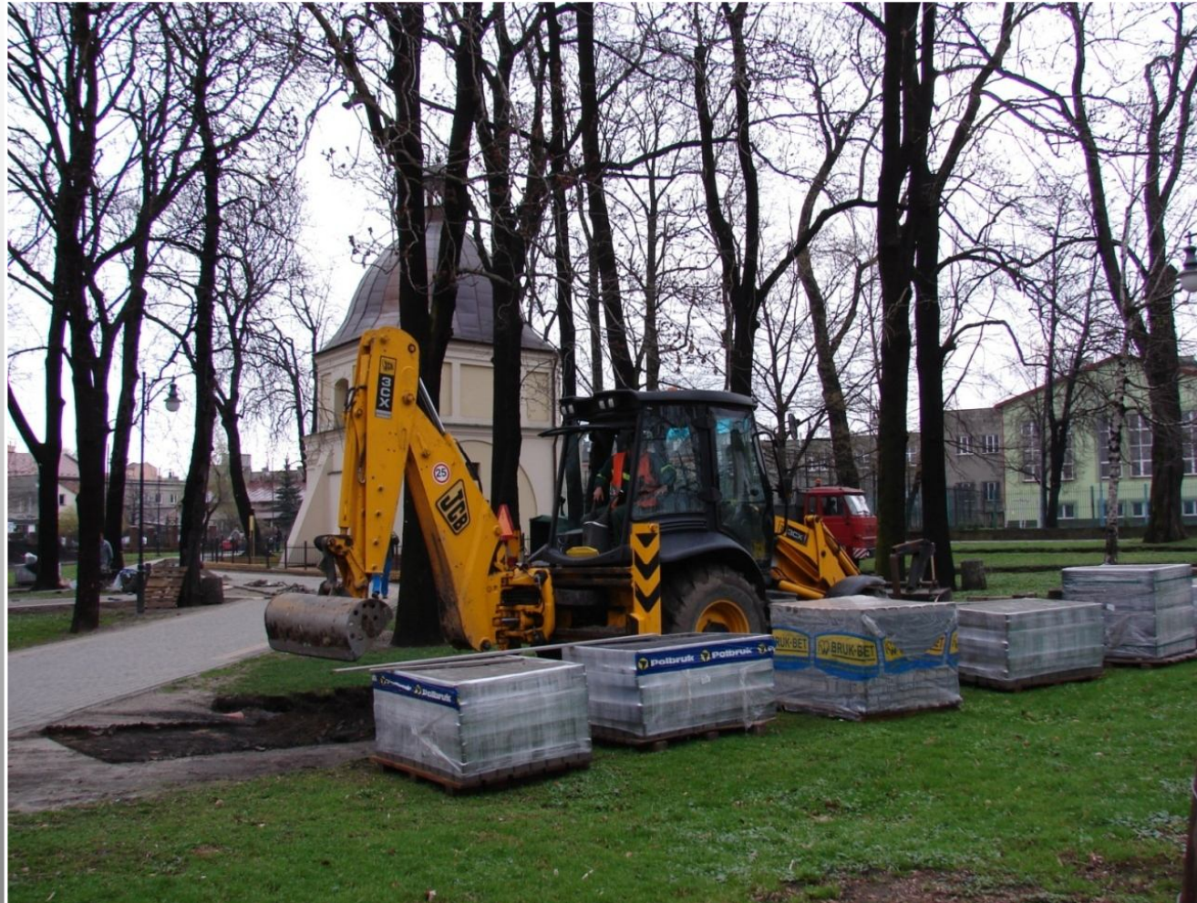
Remont alejek spacerowych.
