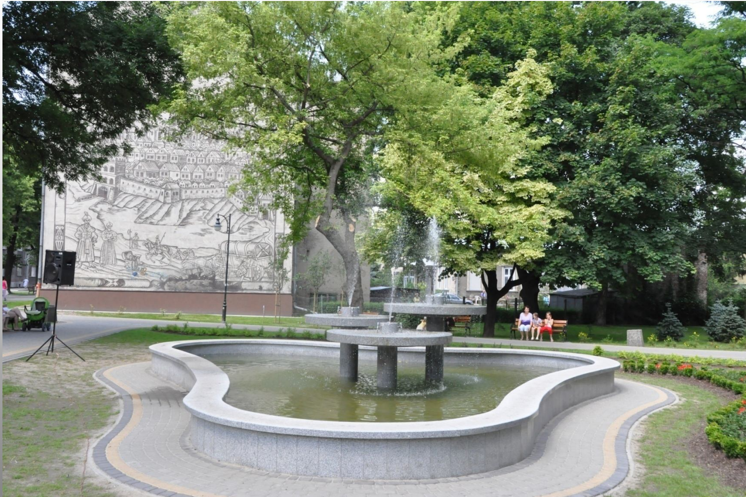
Fontanna po wykonaniu remontu.
