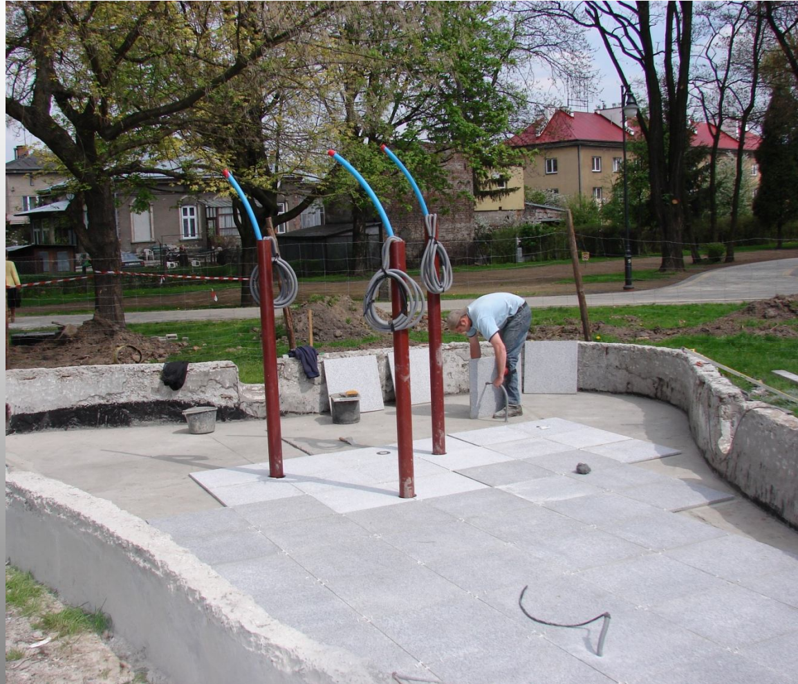
Fontanna w czasie prac remontowych.
