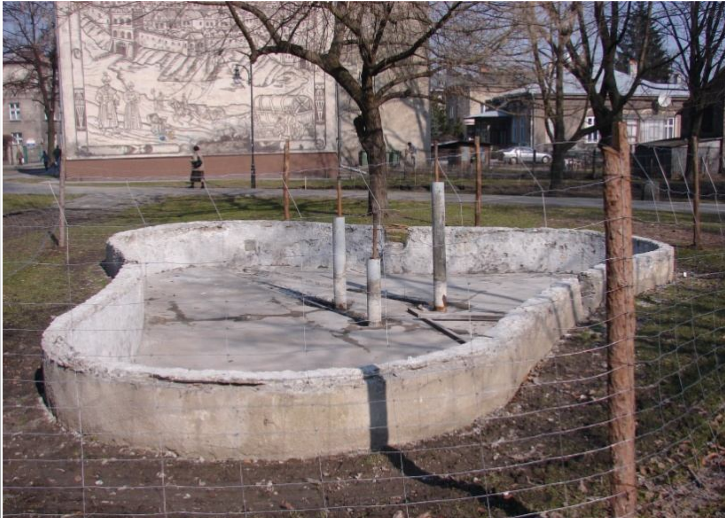
Fontanna w czasie prac remontowych.
