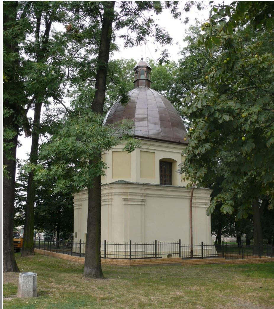
Prezbiterium cerkwi po wykonaniu remontu elewacji w 2008 r.
