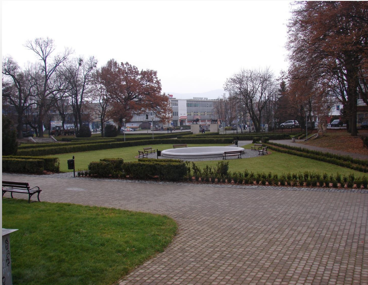
Fragment Parku Pokoju po wykonaniu prac remontowych
