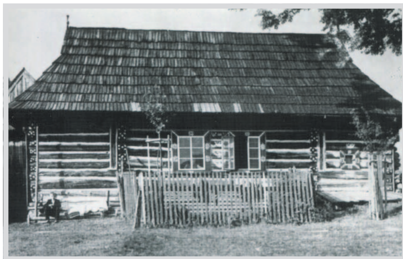
Typowy, trójdzielny dom o konstrukcji zrębowej Gażdżika w Zdziarze, koniec XIX w. Foto V. Vydra, 1965. Ze zbiorów Jána Olejníka
