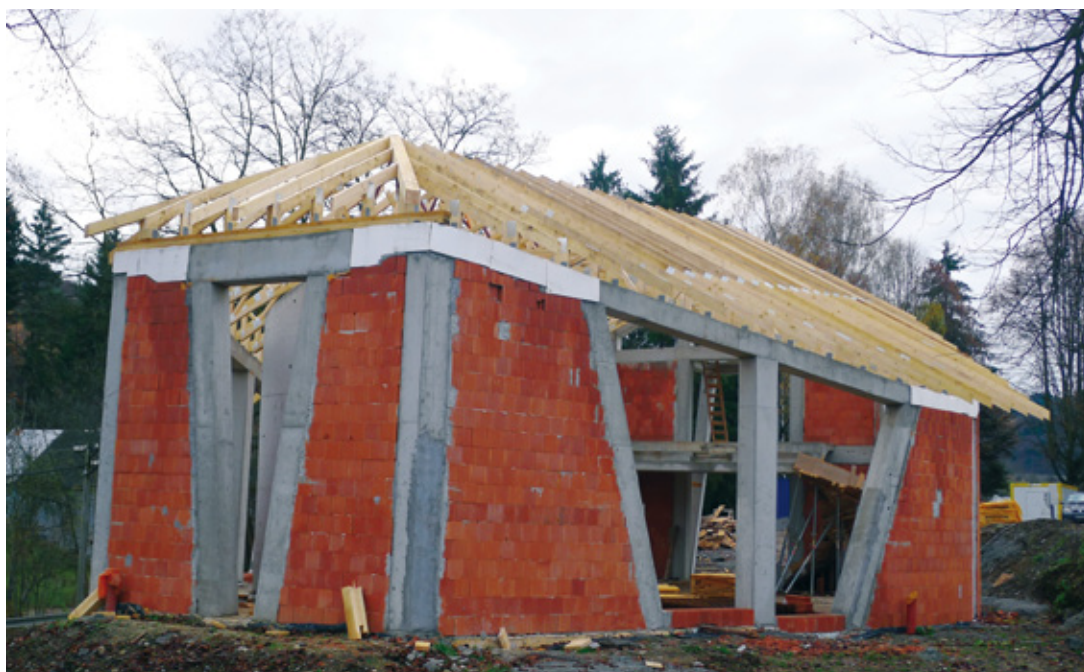
Stavba strešnej konštrukcie chrámu • Budowa konstrukcji dachu kościoła • Construction of the temple's roof
