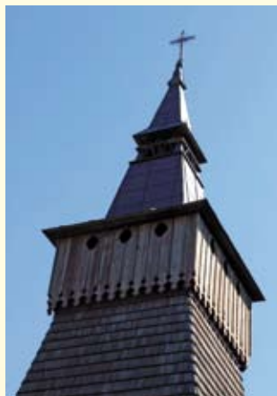
Kościół św. Katarzyny – wieża kościoła. Kostol Sv Katarzyny – veža kostola.
