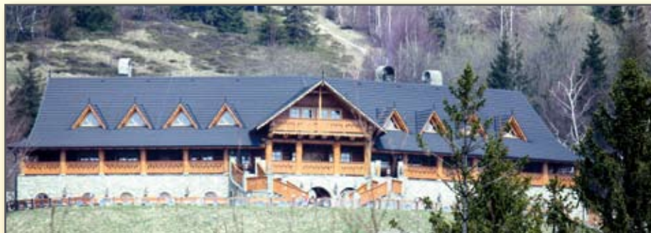
Ustroń Równica – Karczma i Hotel na Równicy / Ustroń Równica - Hostinec a hotel Równica.
